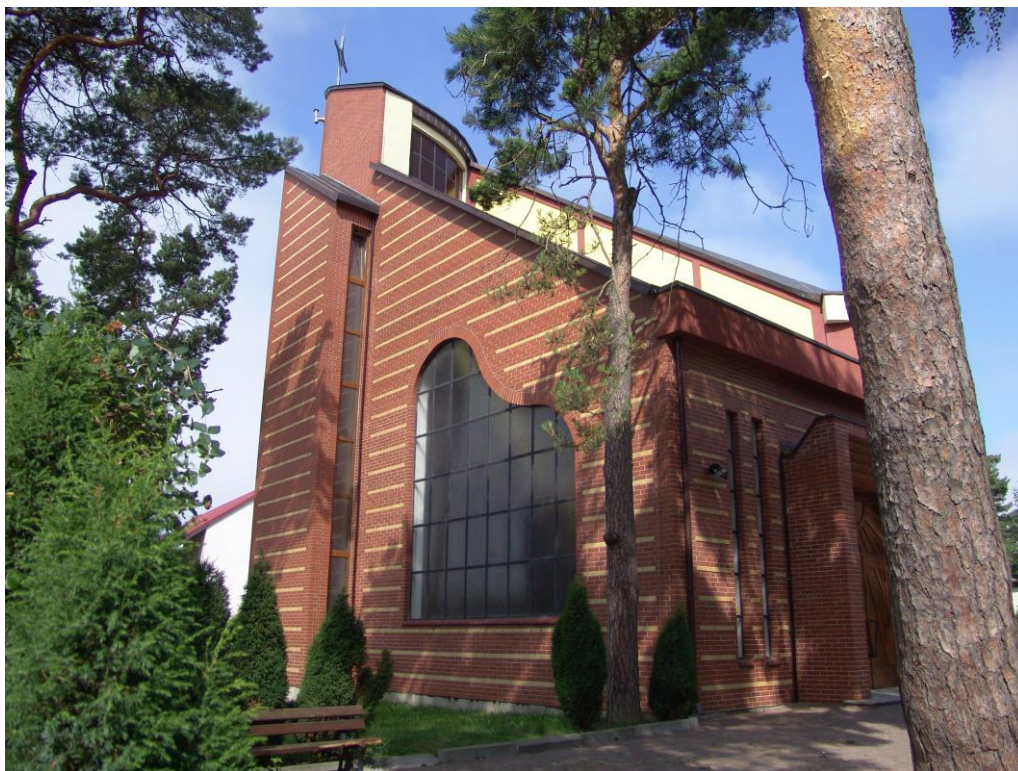
Fot. 157. Kościół p.w. św. Stanisława BM w Niechorzu, widok na część ściany prezbiterium, strona południowa Fot. autor.
