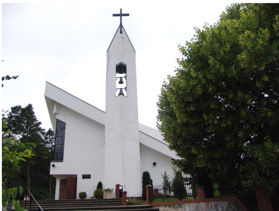
Fot. 90. Kościół p.w. Najświętszego Odkupienia w Pobierowie, widok głównego wejście od strony północnej Fot. autor.
