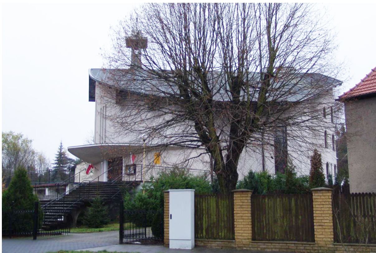
Fot. 102. Kościół p.w. św. Alberta w Szczecinie, widok elewacji północnej Fot. autor.
