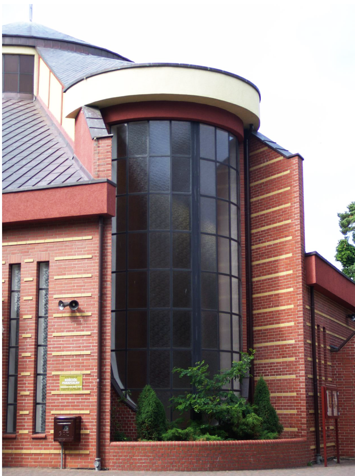
Fot. 156. Kościół p.w. św. Stanisława BM w Niechorzu, widok świetlika Fot. autor.
