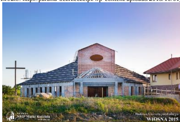
Fot. 170. Kościół p.w. NMP Matki Kościoła, Bezzrecze, w budowie, arch. Jerzy Nowak
