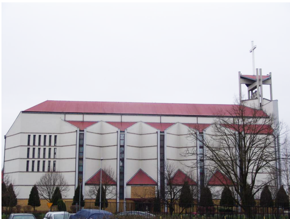
Fot. 116. Kościół p.w. św. Ottona w Szczecinie, elewacja wschodnia Fot. autor.
