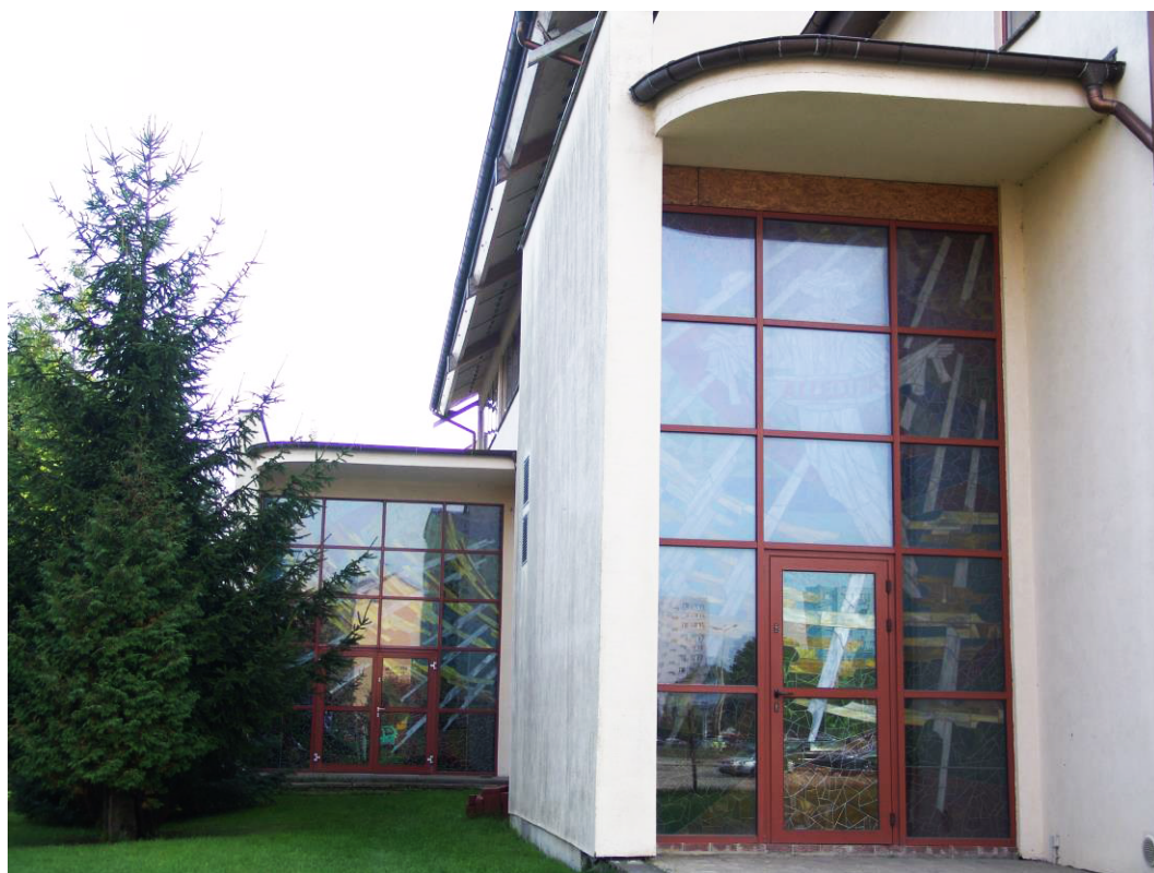
Fot. 142. Kościół p.w. Opatrzności Bożej w Szczecinie, boczne kaplice Fot. autor.
