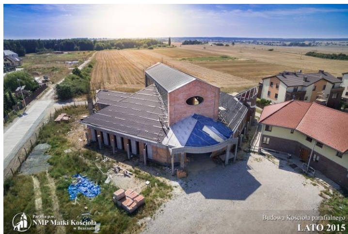
Fot. 169. Kościół p.w. NMP Matki Kościoła, Bezzrecze, w budowie, arch. Jerzy Nowak
