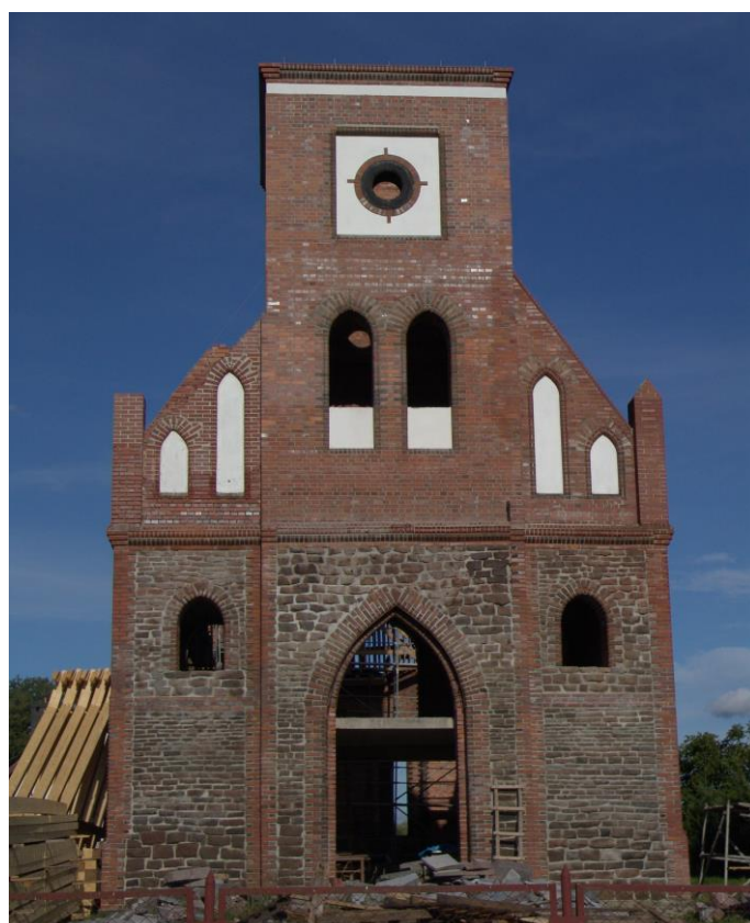
Fot. 168. Kościół w budowie od 2013, fasada wejściowa, Chomino, arch. Adam Barczyk Fot. autor.
