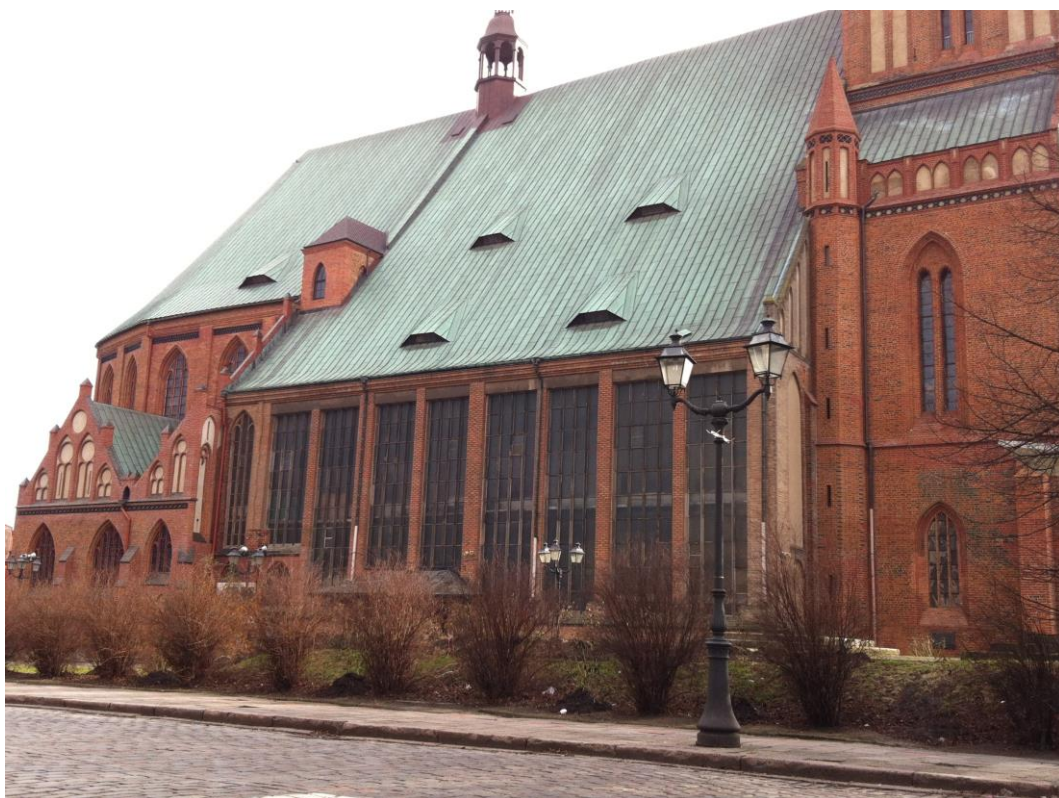
Fot. 59. Katedra św. Jakuba, Szczecin – widok ściany północnej
