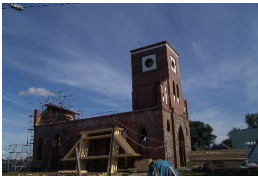
Fot. 167. Kościół w budowie od 2013, Chomino, arch. Adam Barczyk, forma nawiązująca do neoromanizmu, z wykorzystaniem rodzimego materiału otoczeków, granitowych kwart, dostępnej w okolicy cegły rozbiórkowej Fot. autor.
