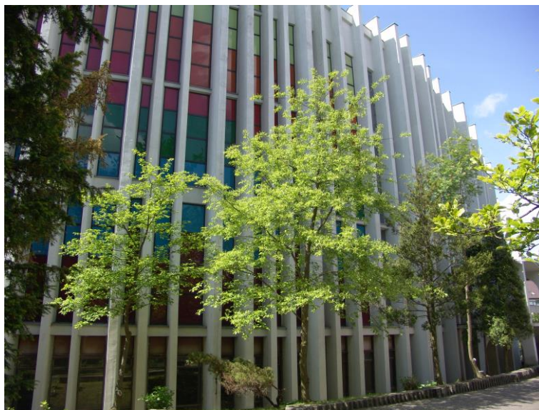
Fot. 63. Kościół p.w. św. Krzyża w Szczecinie, elewacja wschodnia Fot. autor.
