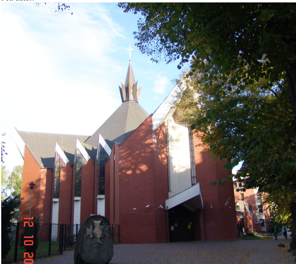
Fot.125. Kościół p.w. św. Dominika w Szczecinie, elewacja frontowa, widok wejścia do kościoła Fot. autor.
