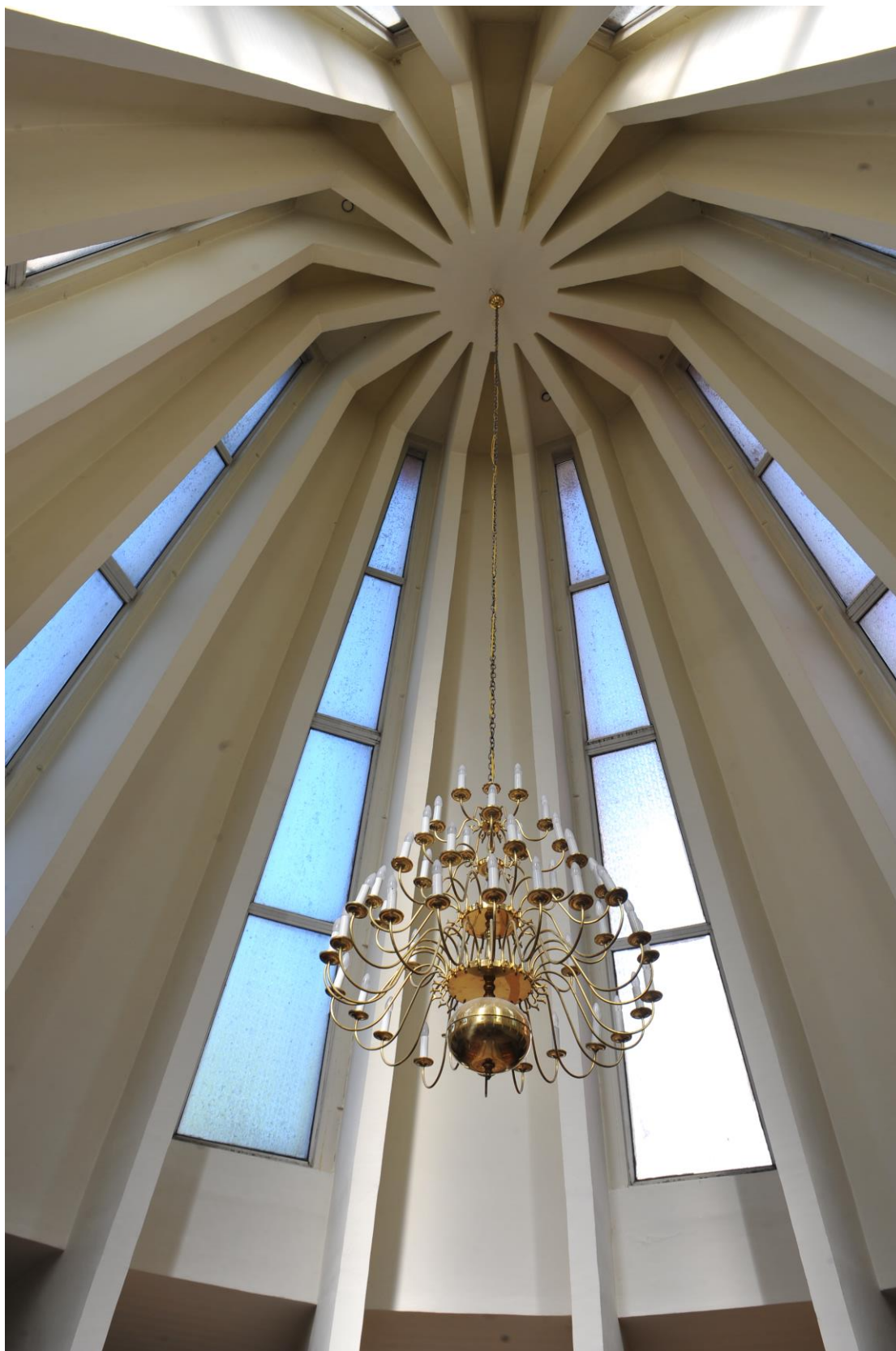
Fot. 83. Kościół p.w. Miłosierdzia Bożego w Szczecinie, wnętrze kaplicy, widok przedstawiający formę przekrycia
