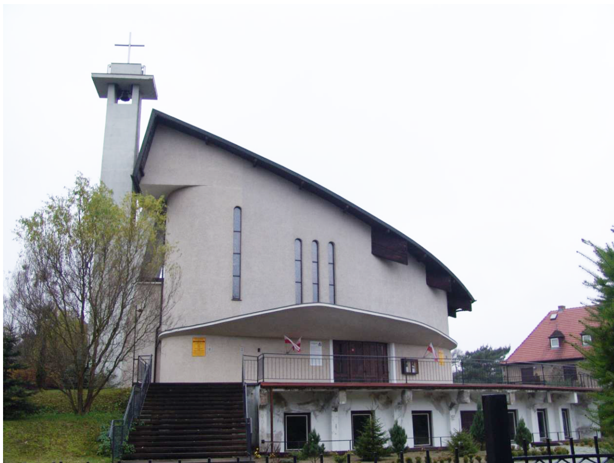
Fot. 98. Kościół p.w. św. Alberta w Szczecinie. Widok od strony wejścia Fot. autor.
