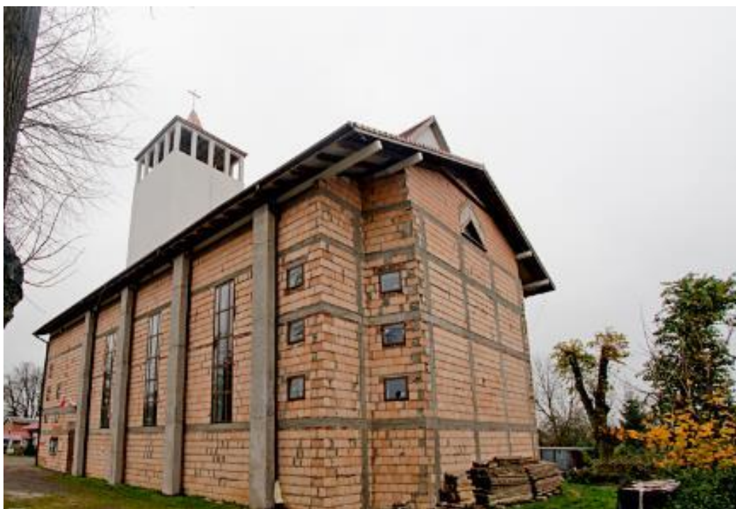
Fot. 163. Kościół p.w. Chrystusa Króla Wszechświata, Dołuje, budowa 27 lipca 2007 Źródło: http://dolujeparafia.pl/ 2015 r.
