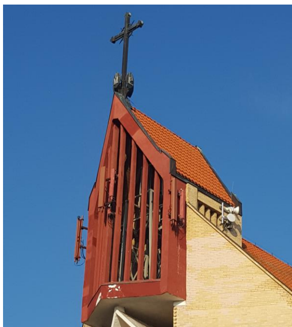
Fot. 110. Kościół p.w. św. Kazimierza w Policach detal sygnaturki Fot. autor.
