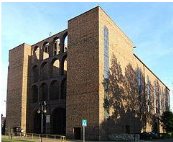
Fot. 9. Kościół p.w. św. Józefa w Zabrzu z około 1931 r., arch. Dominikus Böhm Źródło: https://pl.wikipedia.org/wiki/Kościół_św._Józefa_w_Zabrzu#Architektura_i_wn , 2015 r.
