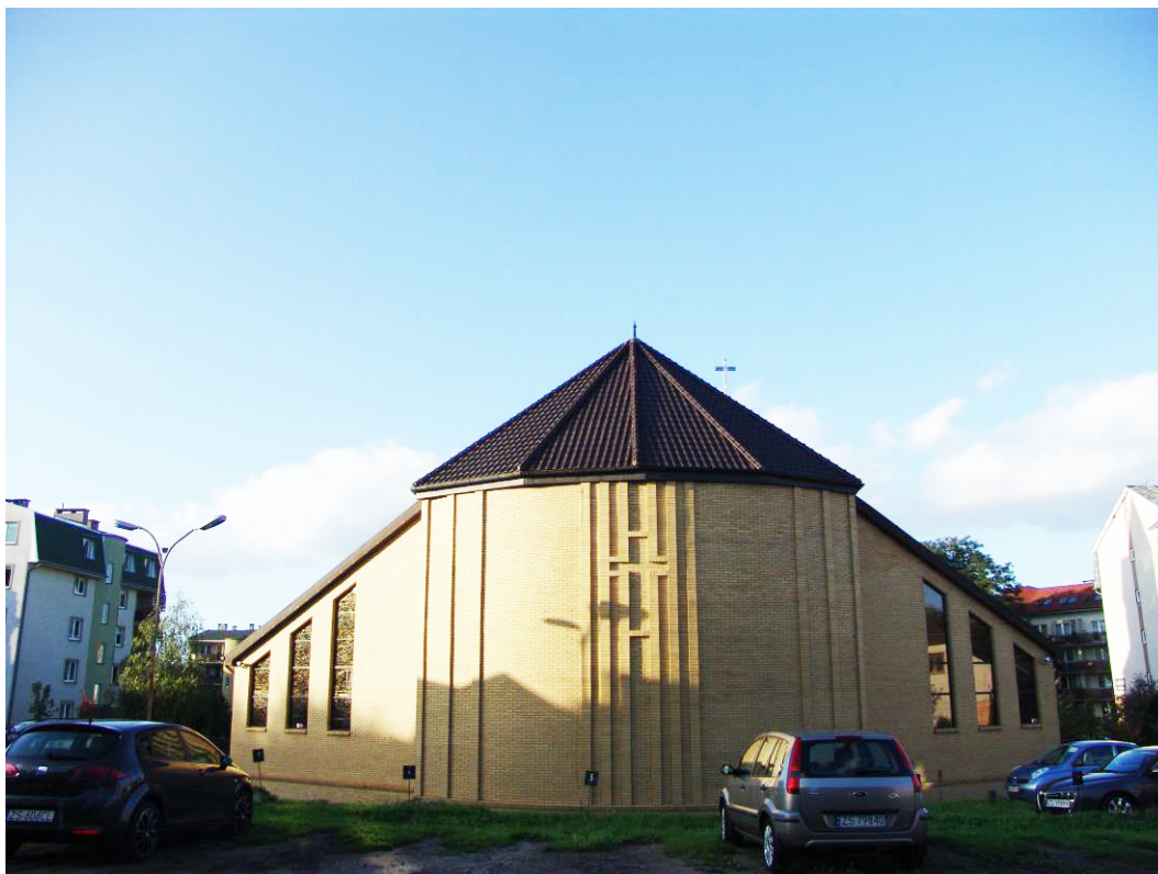
Fot. 149. Kościół p.w. Chrystusa Dobrego Pasterza w Szczecinie, widok absydy Fot. autor.
