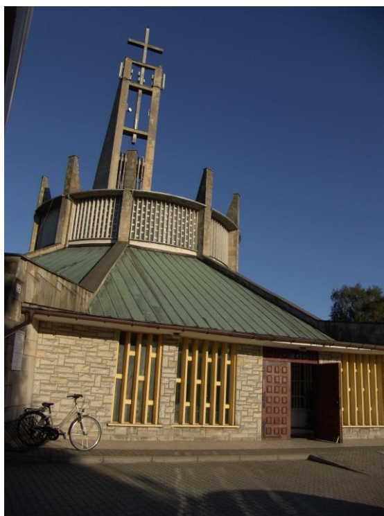
Fot. 73. Kościół p.w. św. Wojciecha BM w Świnoujściu, widok wejścia głównego do kościoła
