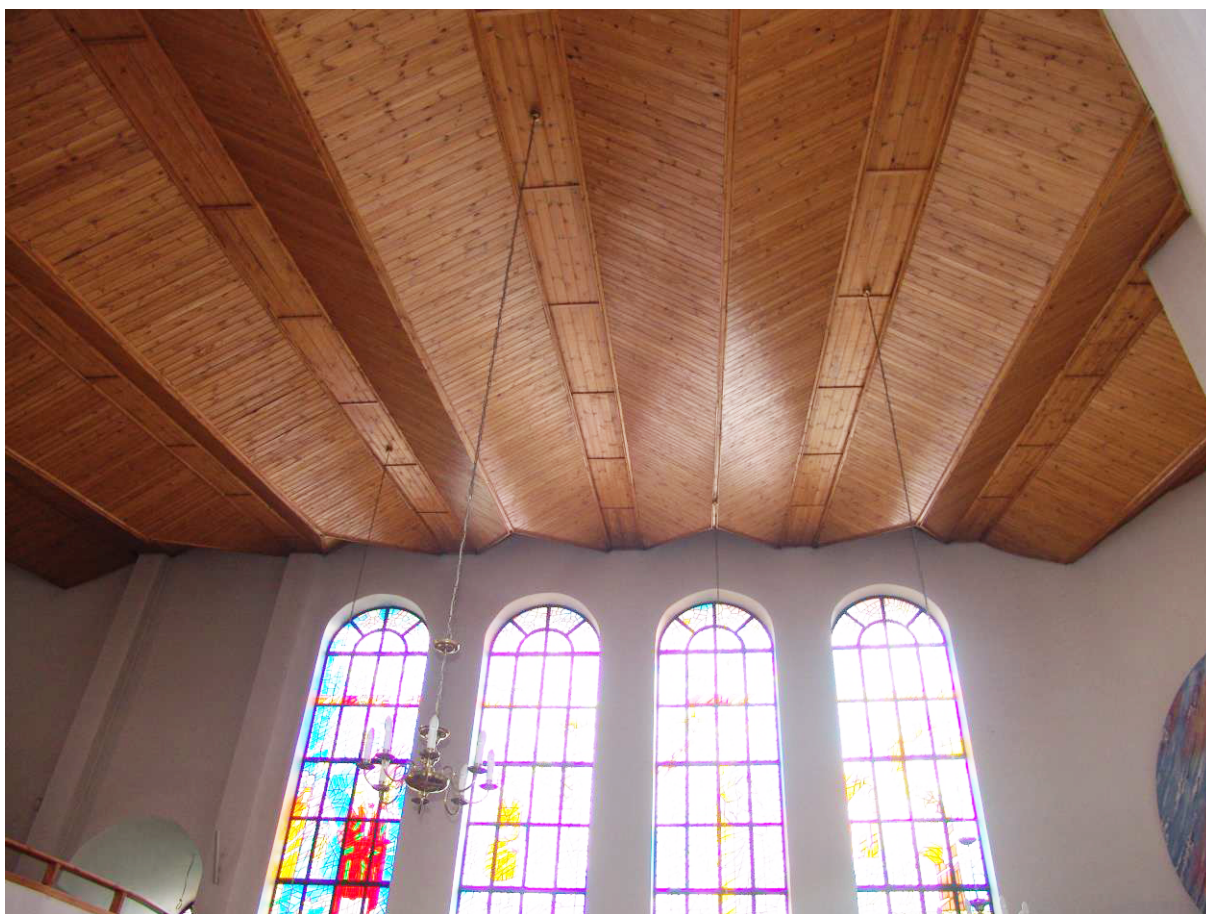
Fot. 105. Kościół p.w. św. Alberta w Szczecinie, widok ściany południowej, wykończenie sufitu Fot. autor.
