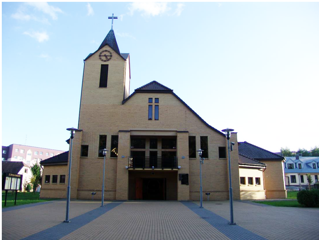
Fot. 147. Kościół p.w. Chrystusa Dobrego Pasterza, elewacja północna Fot. autor.
