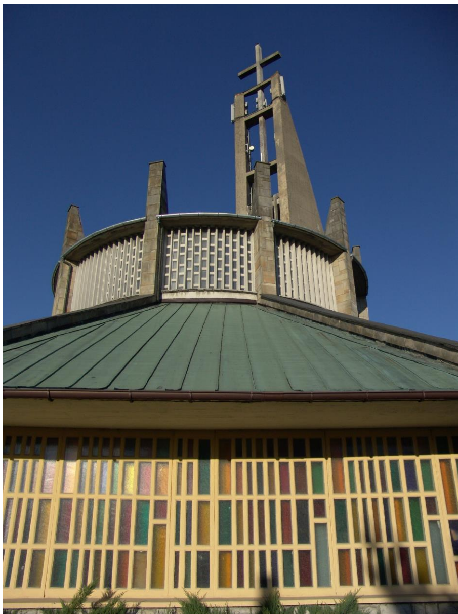
Fot. 76. Kościół p.w. św. Wojciecha BM w Swinoujściu, widok elewacji południowej Fot. autor.
