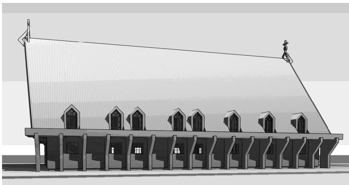
Ryc. 67. Kościół p.w. Bożego Ciała w Szczecinie Widok bryły zrealizowanego kościoła Źródło: opracowanie autorskie.
