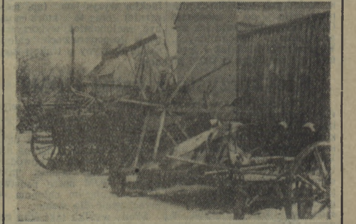
Tak wygląda „widok ogólny” podwórza polczyńskiego GOM-u. Zniwiarci, siewniki i inne maszyny rolnicze stoczone jedna obok drugiej, w opłakany stan, oczekują na remont.
