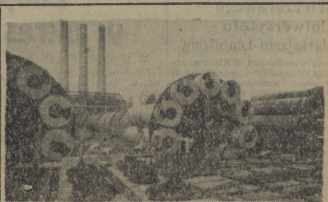
W lubelskim okręgu przemysłowym, jednym z najbardziej nowoczesnych obiektów, jest budująca się cementownia — Rejowiec II. Na zdjęciu: piece obrotowe do wypalania klinkieru. (Fot. CAF)
