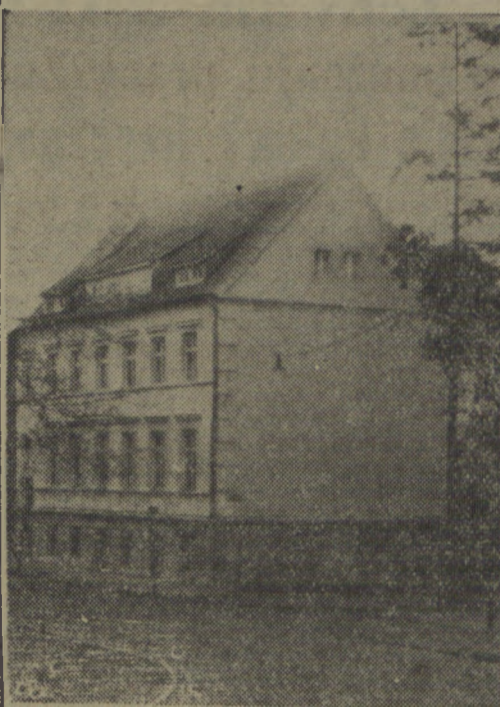
Na zdjęciu: budynek, w którym mieści się Ośrodek Szkolenia Kadry Woj. RN.
