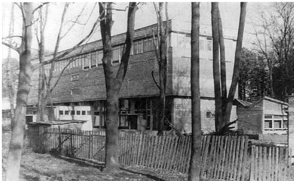
Budowa WiMBP w Koszalinie
