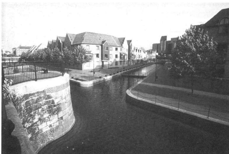
Fot. 16. Widok zachowanego nabrzeża jednego z doków. Źródło: zdjęcie autora
