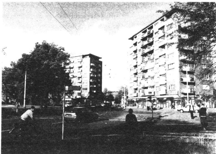
Fot. 8. Widok dwóch budynków wielorodzinnych wzniesionych w latach 70. przy placu Grunwaldzkim. Źródło: zdjęcie autora
