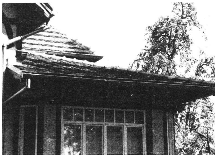
Fot. 30. Przykład budynku z dachem o kącie nachylenia 30^{\circ} . Źródło: zdjęcie autora
