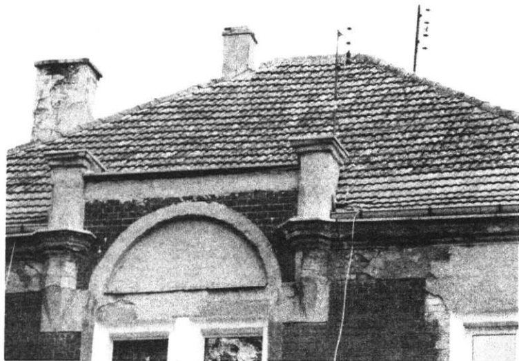
Fot. 41. Przykład budynku z dachem pokrytym dachówką cementową. Źródło: zdjęcie autora
