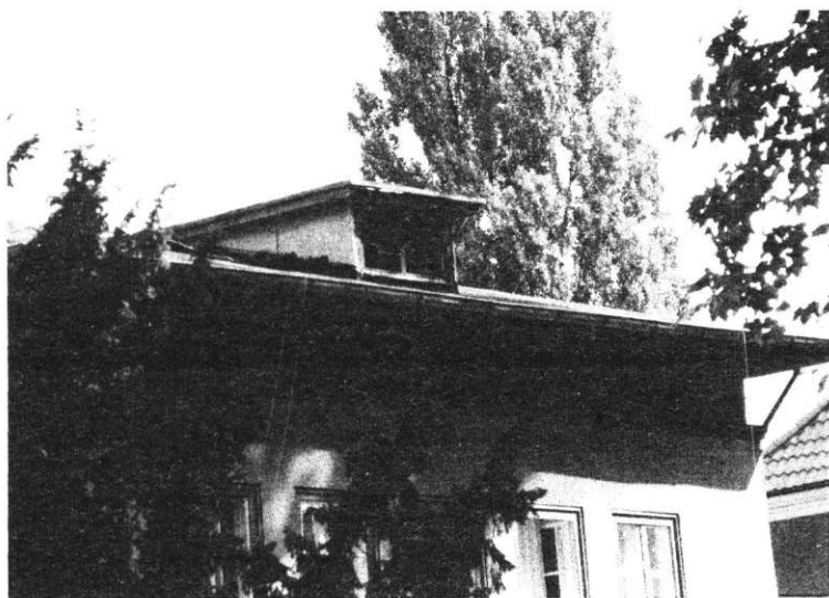
Fot. 29. Przykład budynku z dachem o kącie nachylenia 15^{\circ} . Źródło: zdjęcie autora
