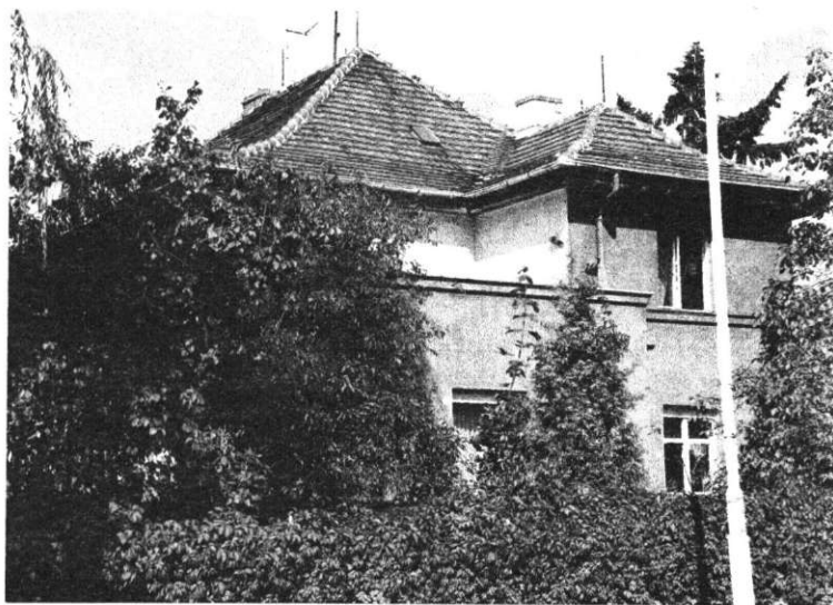
Fot. 40. Przykład budynku z dachem pokrytym dachówką ceramiczną. Źródło: zdjęcie autora
