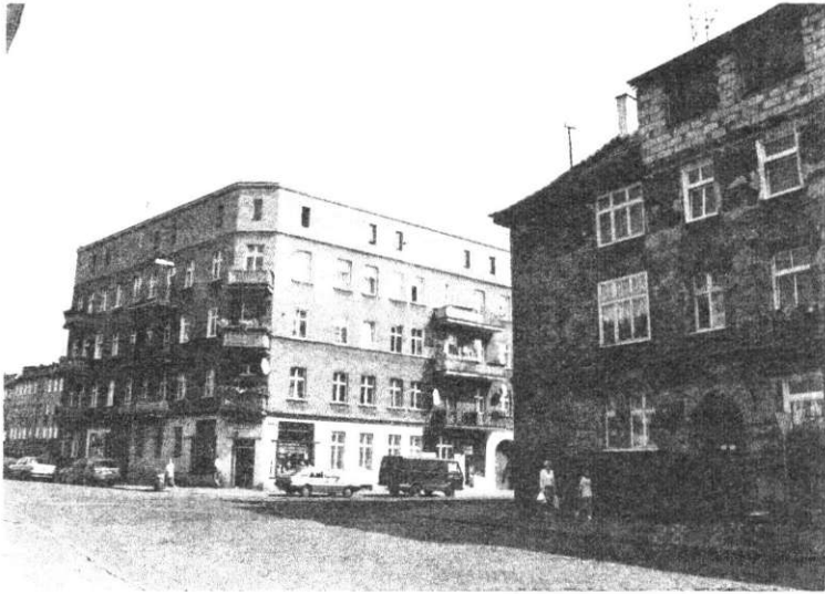
Fot. 52. Fragment zabudowy drugiego zespołu z budynkami o różnych kątach pochylenia połaci dachowych. Źródło: zdjęcie autora
