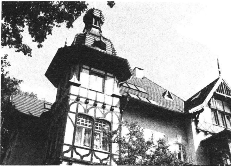
Fot. 33. Przykład budynku z dachem wielospadowym. Źródło: zdjęcie autora
