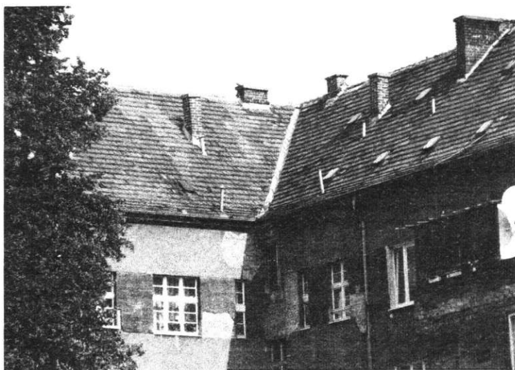
Fot. 51. Przykład budynku z dachem o kącie pochylenia połaci dachowych 45^{\circ} . Źródło: zdjęcie autora
