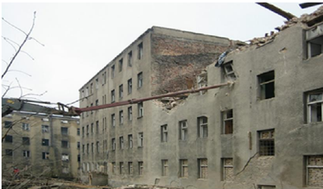
Rys. 2.4 Widok jednej z kamienic Szczecina podczas jej rozbiórki
