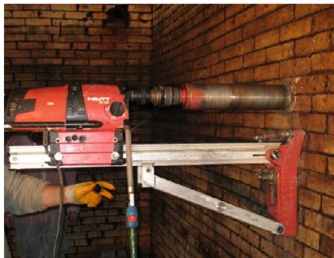
Rys. 4.17 Pobieranie odwiertu rdzeniowego z konstrukcji murowej [134]
