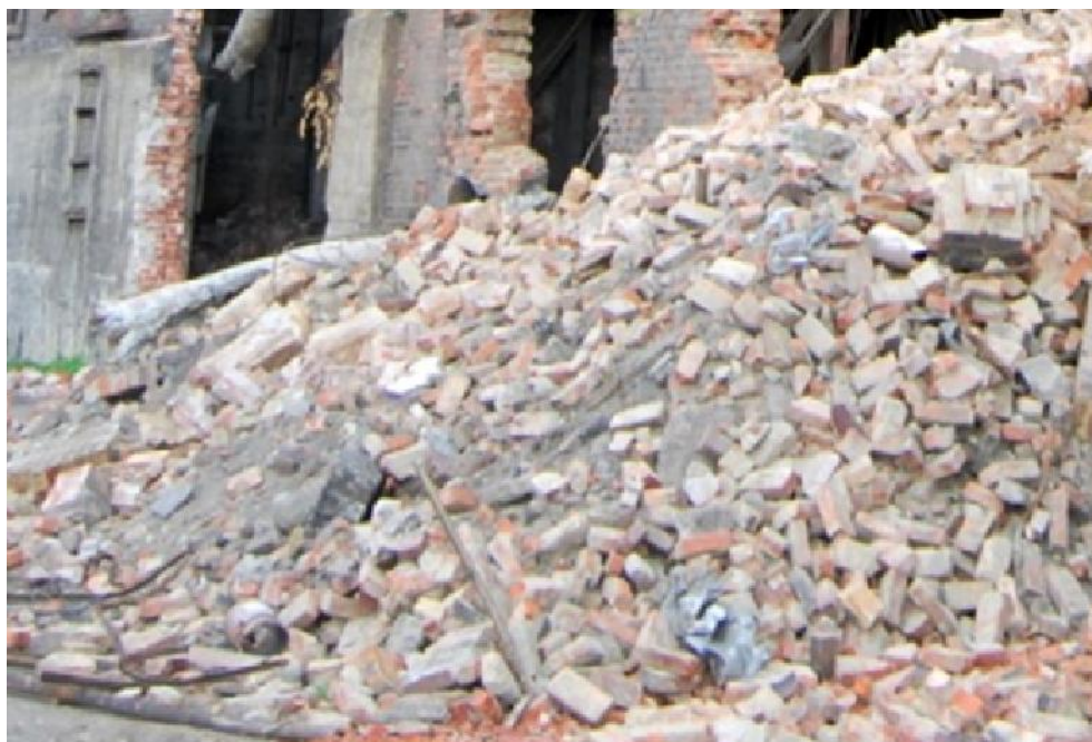
Rys. 4.6 Materiał z rozbiórki byłej Fabryki Papieru "Szczecin - Skolwin" do bada wytrzymała ciowych cegły i zaprawy
