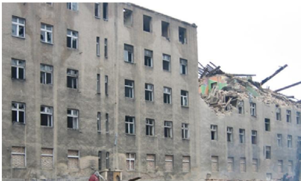
Rys. 4.1 Kamienica w centrum Szczecina decyzją Powiatowego Inspektora Nadzoru Budowlanego poddana rozbiórce
