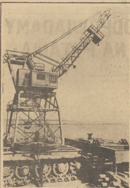
NA BUDOWIE Głównego Kanału Turkmęńskiego. Na zdjęciu — dźwig w Tachitasz.
