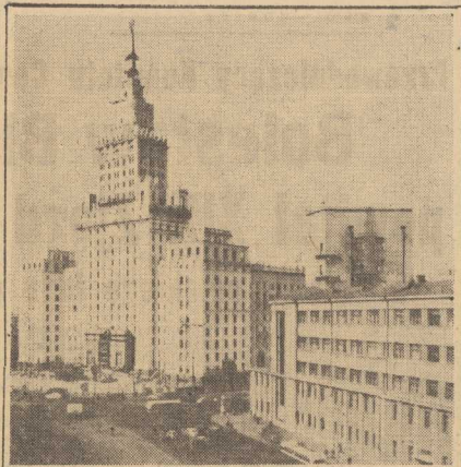
BUDOWA wieżowca Ministerstwa Komunikacji przy Czerwonych Wrotach w Moskwie.
