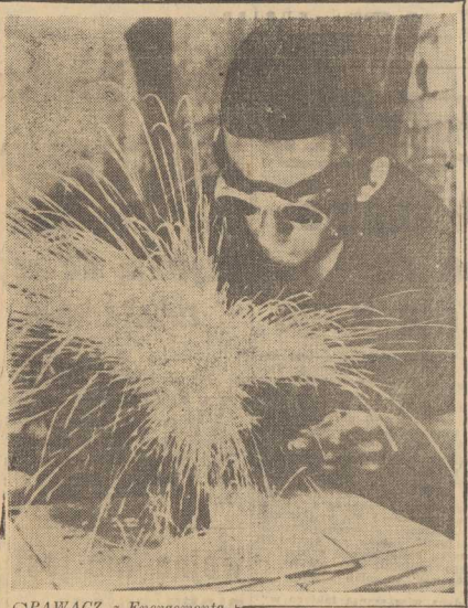
SPAWACZ z Energomontażu BRONISŁAW LANGE pracuje przy rurkach z przegrzewaczy pary. Setki metrów takich rur wmontowano już w kilkupiętrowe ciepłownice wielkiego kotła szczecińskiego elektrowni. Z reportażu na str. 3 dowiedzieć się o tym, jak nasza elektrownia staje się potężną fabryką energii.
