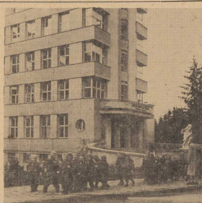
GLEBOKA troska naszego ludowego państwa o młode pokolenie znalazła min. wyraz we wspólnym dziele budownictwa mieszkaniowego — sanatorium przedzjazdowym im. W. Patroskiego w Rabce-Zdroju. Oddany w ub. roku do użytku nowoczesny zespół budynków o kubaturze ponad 70 tys. m. sześć, urządzony został, w oparciu o najlepsze wzory tego rodzaju ośrodków leczniczych w Związku Radzieckim. Idealne położenie sanatorium — na bogato zalesionych terenach górskich, udrążających klimat oraz wysoki stopień nasłonecznienia stwarzają doskonałe warunki leczenia.
