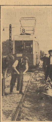
DZIĘKI robotnikom szczytńskiego MPK miasto nasze zostało jeszcze jedno udogodnienie komunikacyjne, wiadukt na ul. Gdańskiej.
