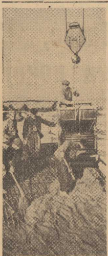
POJEŁMNIKI do zapraw i betonów znalazły szerokie zastosowanie przy budowie hal produkcyjnych kombinatu bawełnianego w Zambrowie. (CAF)
