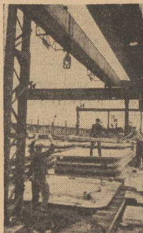
FRAGMENT Bazy Zaopatrzenia nowej Pałacu Kultury i Nauki na Jelonkach — płyty stropowe przygotowane do transportu na budowę. Płyty tego rodzaju coraz częściej stosuje się na polskich budowach. (CAF)
