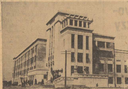
W SZENYANG (Mukden) w pobliżu Nanhu wybudowana została Szkoła Inżynierska, największa tego rodzaju szkoła w Chinach Ludowych. Na zdjęciu: Jeden z budynków Szkoły Inżynierskiej.
