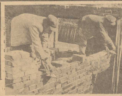
BRYGADA Mariana Uby ukończyła budowę parteru ze stropami — dziś wyciąga już pierwsze piętro.
