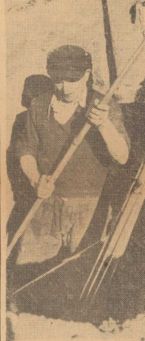
MIECZYSLAW BARTOSIEWICZ łączy cienkie rury w jedną całość, przy pomocy których odnajdzie uszkodzenie dawnego rurociągu.
