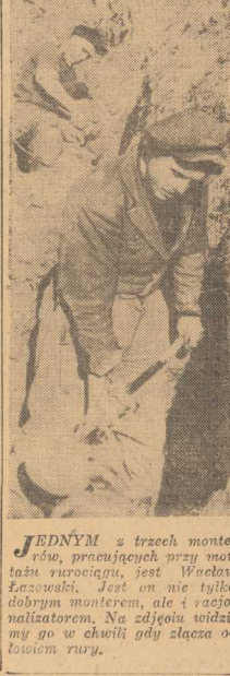
MIECZYSLAW BARTOSIEWICZ łączy cienkie rury w jedną całość, przy pomocy których odnajdzie uszkodzenie dawnego rurociągu.
