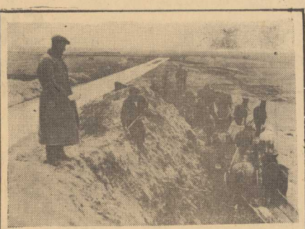
CHŁOPI z gromad, Kuligi, Sikora, Stoczek i Cieszevo pracują ochotniczo w ramach czynu społecznego przy budowie głównego kanału kuwaskiego. (CAF)
