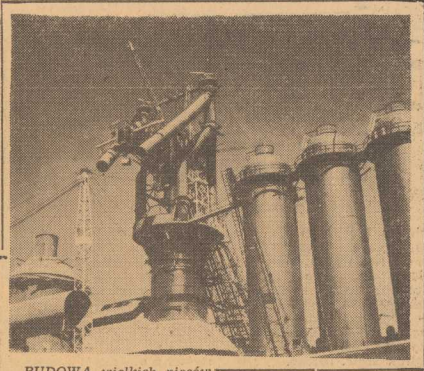
BUDOWA wielkich pieców w hucie im. Bolesława Bieruta. Na zdjęciu: fragment budowy. (CAF)
