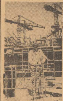
Montaż stalowej konstrukcji sali kongresowej.
