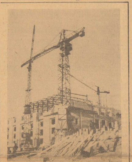
Budowa części sportowej Pałacu.
