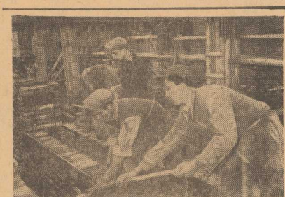
CELEM uczczenia 10 rocznicy powstania Polskiej Partii Robotniczej ZMP-owcy zatrudnieni przy budowie Marszałkowskiej Dzielnicy Mieszkalniczej podjęli liczne zobowiązania produkcyjne: Brygada mużarska Tadeusza Paska przyznieszy o dwa dni wykonanie fundamentowych piwnic na bloku 15. (CAF fot. Nowosielski Antoni)
