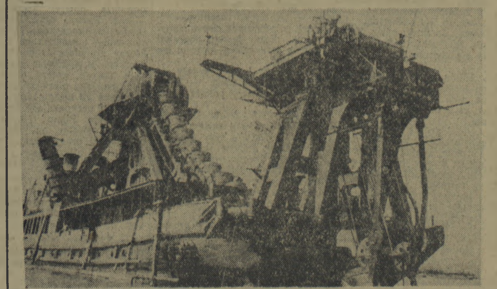
W czasie prac, przy wykopie pod fundamenty Kujbyszewskiej Elektrowni Wodnej, duże usługi oddaje pogłębiarka „Piatiletka”. Maszyna ta wydobywa w ciągu doby tysiące metrów sześciennych żwiru i skalistego gruntu. Na zdjęciu: Pogłębiarka „Piatiletka”. Fot. CAF
