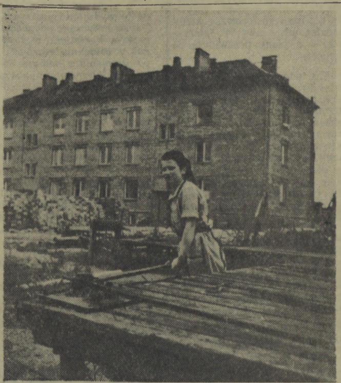
W Ożimku w woj. opolskim buduje się nowe osiedle mieszkaniowe obliczone na 50 tysięcy mieszkańców. Przy budowie — z pomocą biblioteki ludowej stanowią 15 proc. Budowa ta jako wzorowa zdobyła w IV kwartale 1951 r. sztandar przechodni we współzawodnictwie pracy. Na zdjęciu: zbrojarka Elżbieta Wojtynek, była średnio robia chłopka wykonująca 175 proc. normy.
