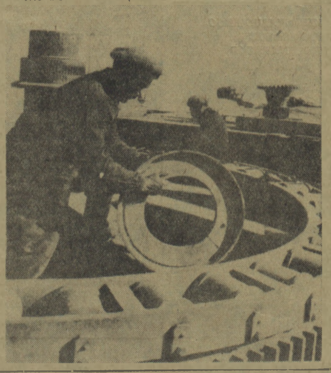
NA BUDOWIE KANAŁU TURKMEŃSKIEGO
