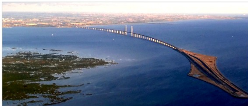
Rys 3.5. Pełnomorska przeprawa mostowa Oresund nad cieśniną Sund.
