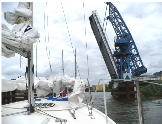
Rys.3.3 Most z przesłem uchylnym w Dziwnowie
