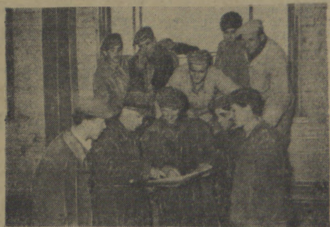
Ostatnia odprawa prądu budowlanych nowouru- chomionego obiektu. Na zdjęciu: Stoją w pierwszym rzędzie od lewej — pomoc murarska ZMP-owiec Jan Marszałek osłagający 204 proc. normy, kierownik budo- wy obiektu Henryk Granek, majster murarski Jan Ko- łucki, brygadziśta brygady spawaczy Jan Oraczewski i murarz Stanisław Piszczuk. F—fot. Nowosielski
