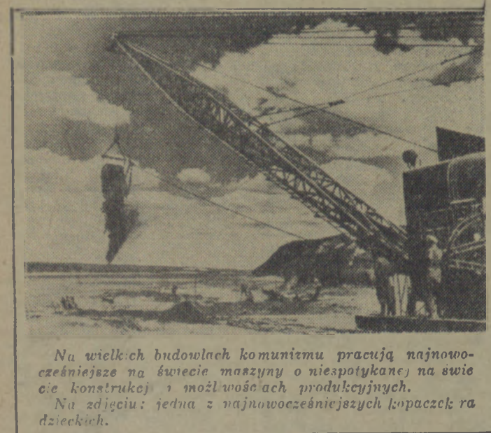
Na wielkich budowlnach komunizmu pracują najnowocześniejsze na świecie maszyny o niespotykanej na świecie konstrukcji i możliwościach produkcyjnych. Na zdjęciu: jedna z najnowocześniejszych koparek radzieckich.
