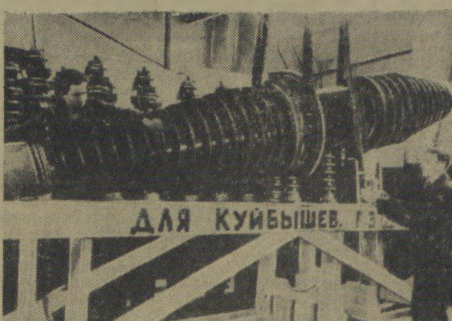
Wiele moskiewskich fabryk wykonuje zamówienia dla wielkich budów komunizmu — Kanatu Wolga — Don i elektrowni wodnych w Kujbyszewie i Stalingradzie. Na zdjęciu: przygotowanie do transportu części urzędeń dla budowy kujbyszewskiej elektrowni wodnej.
