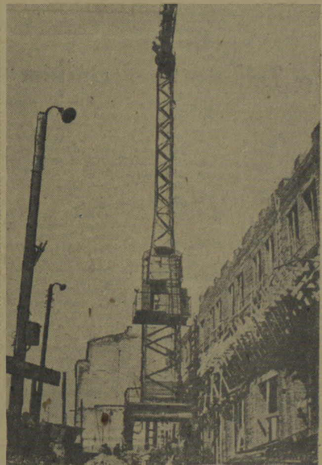
Na budowie MDM
