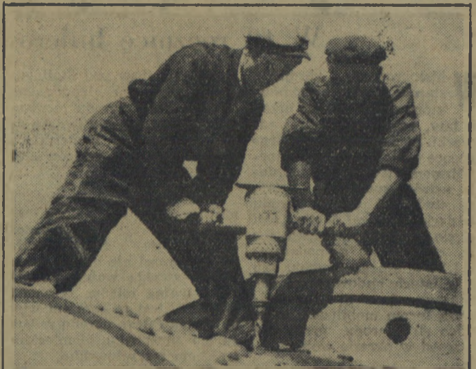
Z ogromnym entuzjazmem i zrozumieniem subskrybują społeczeństwo polskie Narodową Pożyczkę Rozwoju Sił Polski. Na zdjęciu: monterzy pracujący przy rozwiercaniu otworów trzonu pieca Cementowni Wierzbica — Stanisław Szwed i Aleksander Sasal subskrybowali Pożyczkę w wysokości swych 14 dniówek.
