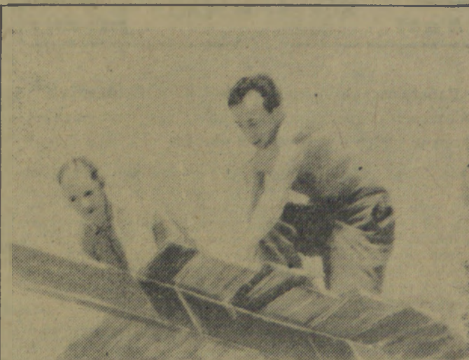
Na budowie Osiedla przodują cieśle: Sergiusz Czesny i Adam Matłowski.
