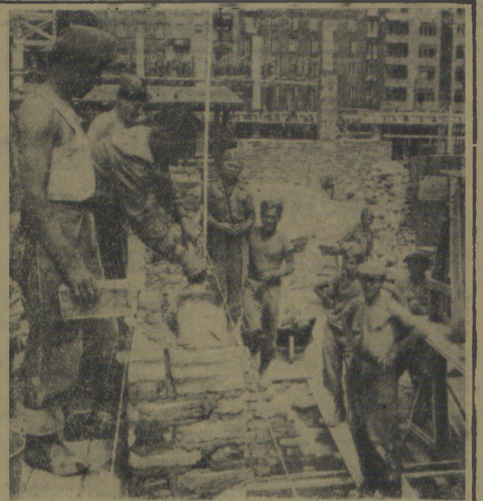
Znany przodownik murarski i racjonalizator, obecnie instruktor modernizacji produkcji — Wacław Poręcki demonstruje na budowie Marszałkowskiej Dzielnicy Mieszkaniowej rozkładanie zaprawy przy pomocy specjalnie do tego przystosowanej szuflki. Próbowi tym, przyglądają się inni pracownicy SP z brzołami 1 B.
