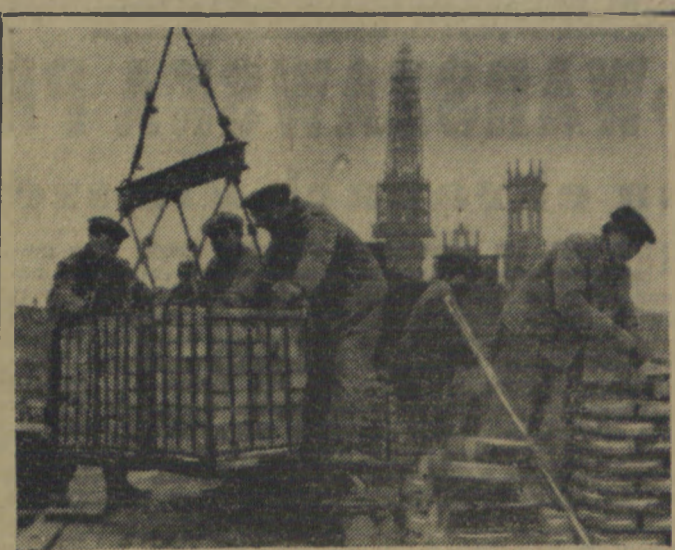
Na budowie bloków MDM od kilku dni są w zastosowaniu „zasobniki” do przenoszenia cegieł. Trzy składy zasobników podnosi na miejsce przeznaczenia 42-metrowy radziecki dźwig. Na zdjęciu specjalna grupa transportowa odbiera „zasobniki” z dźwigu i ustawia cegły w odpowiednim miejscu. W skład grupy wchodzi: Jan Wypyski i Czesław Perski. Poza tym na zdjęciu: murarz Apolinary Dypkiński (stoi na wlinku). W głębi — pomoc murarza — Szczepan Woszczyk.
