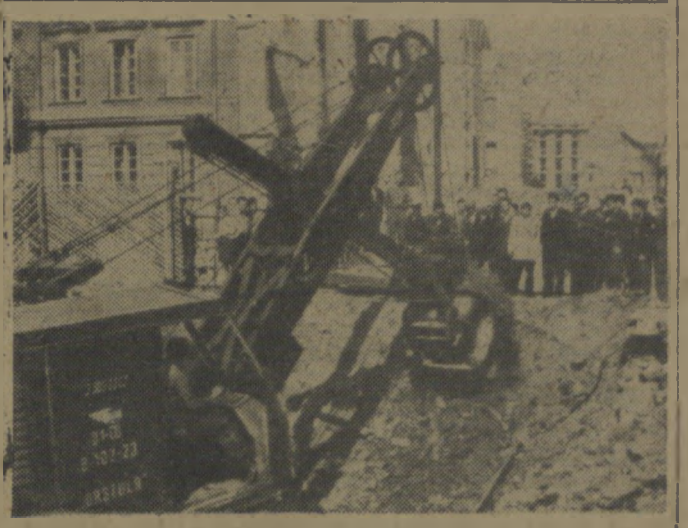
Odbudowa stolicy stała się możliwa dzięki pomocy Związku Radzieckiego. Na zdjęciu: wielka kopaczka produkcji radzieckiej przy pracy.
