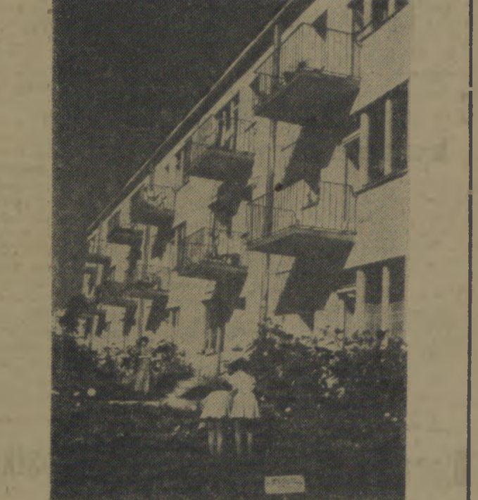
Fragment pięknego bloku mieszkalnego w jednym z nowych osiedli robotniczych, rosnących w Warszawie (Mokotów).
