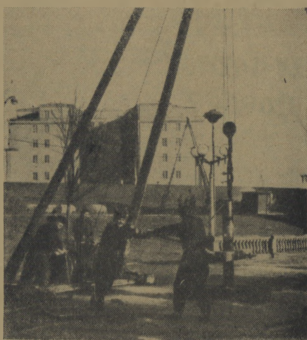
W wielu punktach Warszawy na trasie przyszłej szybkiej kolei miejskiej „Metra” dokonywane są próbnego wiercenia. Na zdj.: prace wiertnicze na Mariensztacie w Warszawie.
