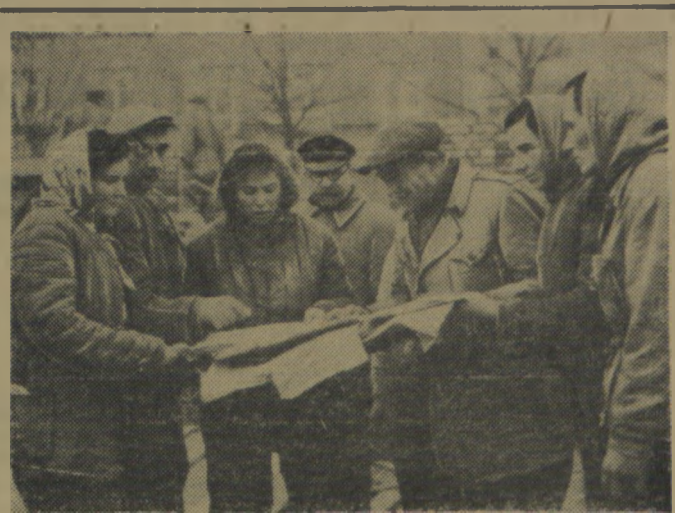
Na MDM, największej obecnie budowie w Warszawie, kobiety pracują na równi z mężczyznami. Przy budowie bloku 7a pracują cztery zespoły „dwójkowe” kobiet-murarzy. Na zdjęciu: robocza narada. Od lewej na pierwszym planie Maria Jagiełło, Władysław Szadkowski — znany rekordzista murarski, a obecnie majster — Halna Wiśniewska, Stanisława Szarżłowska, Józef Fronk, Genowefa Skowrońska i Irena Golaszewska, z tyłu — majster terenowy Michał Antoniuk (w okularach).
