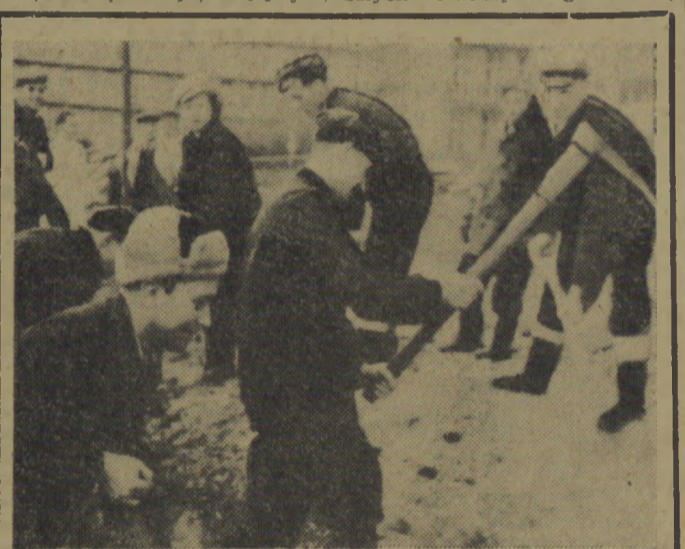
Studentzi Akademii Medycznej pracują z zapalem. Wykop pod fundamenty powiększa się z każdą godziną.
