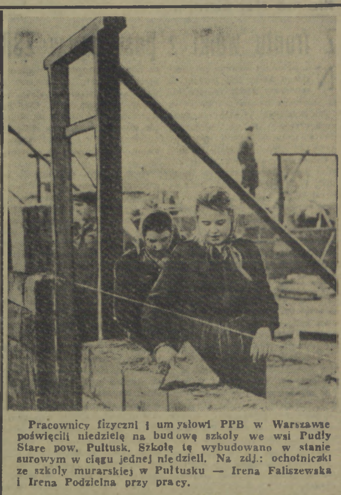
Pracownicy fizyczny i umysłowi PPB w Warszawie poświęcili niedzielę na budowę szkoły we wsi Pudły Stare pow. Pultusk. Szkołę tę wybudowano w stanie surowym w ciągu jednej niedzieli. Na zdj.: ochotniczki ze szkoły murarskiej w Pultusku — Irena Faliszewska i Irena Podzielnia przy pracy.
