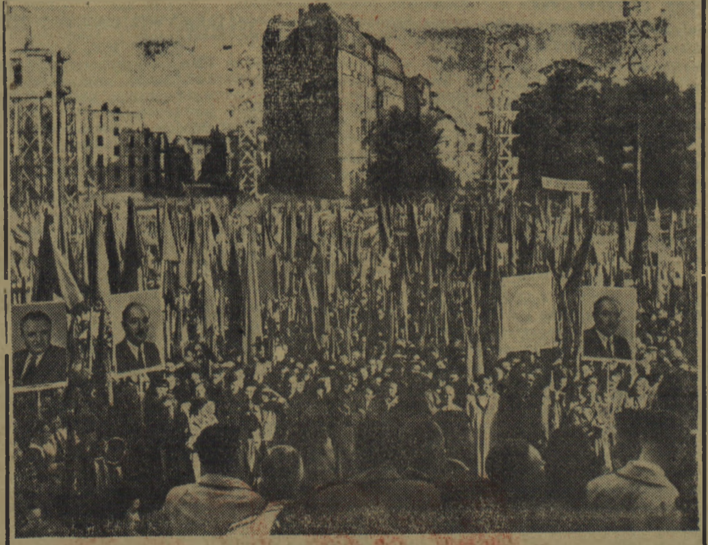
Na Pl. Jedności Robotniczej przed Politechniką Warszawską odbył się przedwczoraj potężny wiec z udziałem 100 tysięcy robotników, pracowników i młodzieży, w którym lud Warszawy, wyrażając postawę całego narodu demonstrował swą zdecydowaną wolę walki o utrzymanie pokoju.
