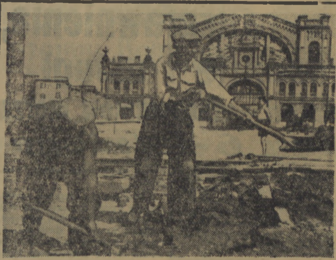
Głównym miejscem pracy w Miesiącu Odbudowy Warszawy będzie trasa N-S. Przed 1 września będzie gotowa nowa boznica kolejowa, umożliwiająca dojazd na miejsce odgruzowania kilkudziesięciogonowym pociągom.
