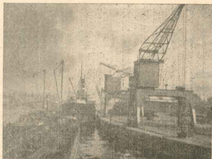
Dźwigi przy pracy
