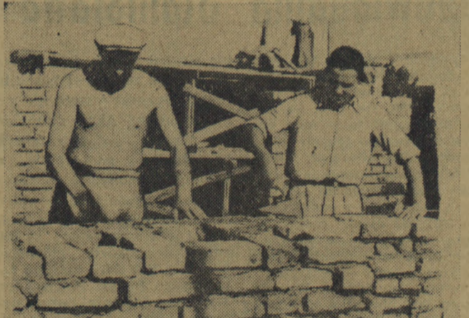
Dwójka murarska: Białoszewski i Kalina, szybko wyciąga mury kominowe centralnego ogrzewania.
